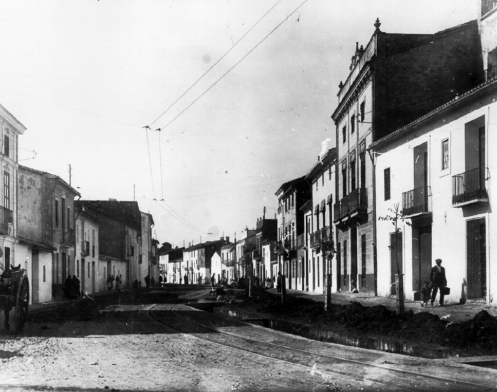
El carrer de Vora séquia ha estat un dels principals carrers d'entrada al centre de la població. Era el lloc per on circulava el tramvia i discorria la séquia principal (AMT. Foto núm. 54).
